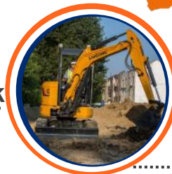
市政建设 Municipal Construction
