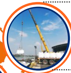
高空起吊 Lifting
