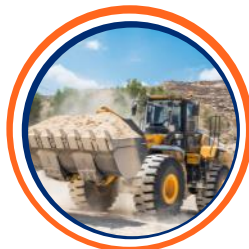
土石方 Earth and Stone Work
